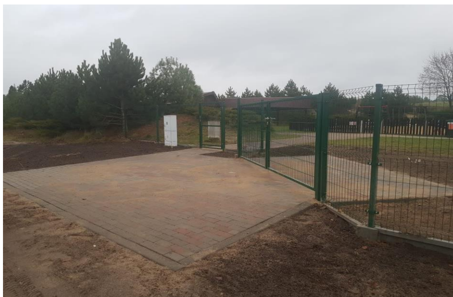
Fot. Ogrodzenie w Rudnej.
